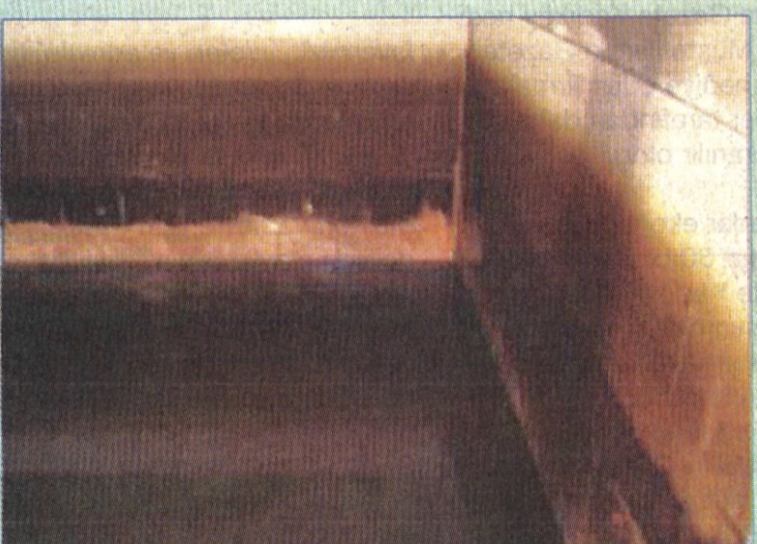
Su deposunun temizlenmeden önceki hali
